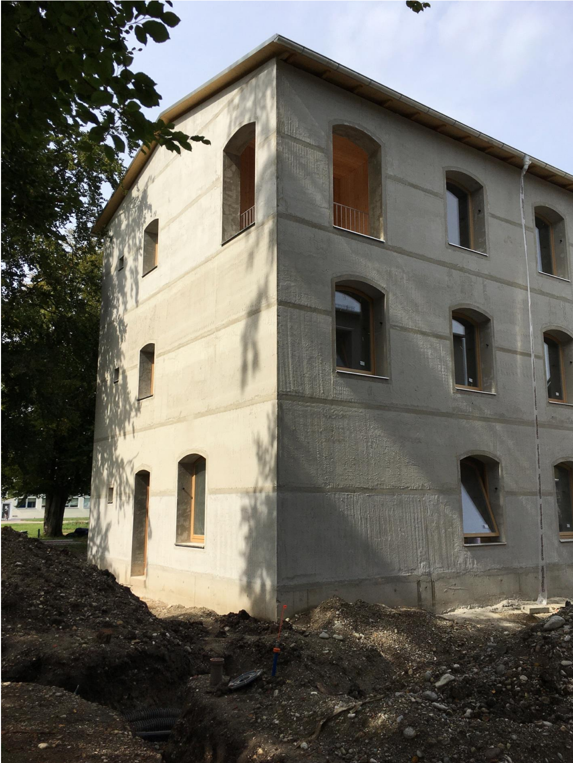
Abbildung 68: Das Mauerwerkshaus von Südosten gesehen.
