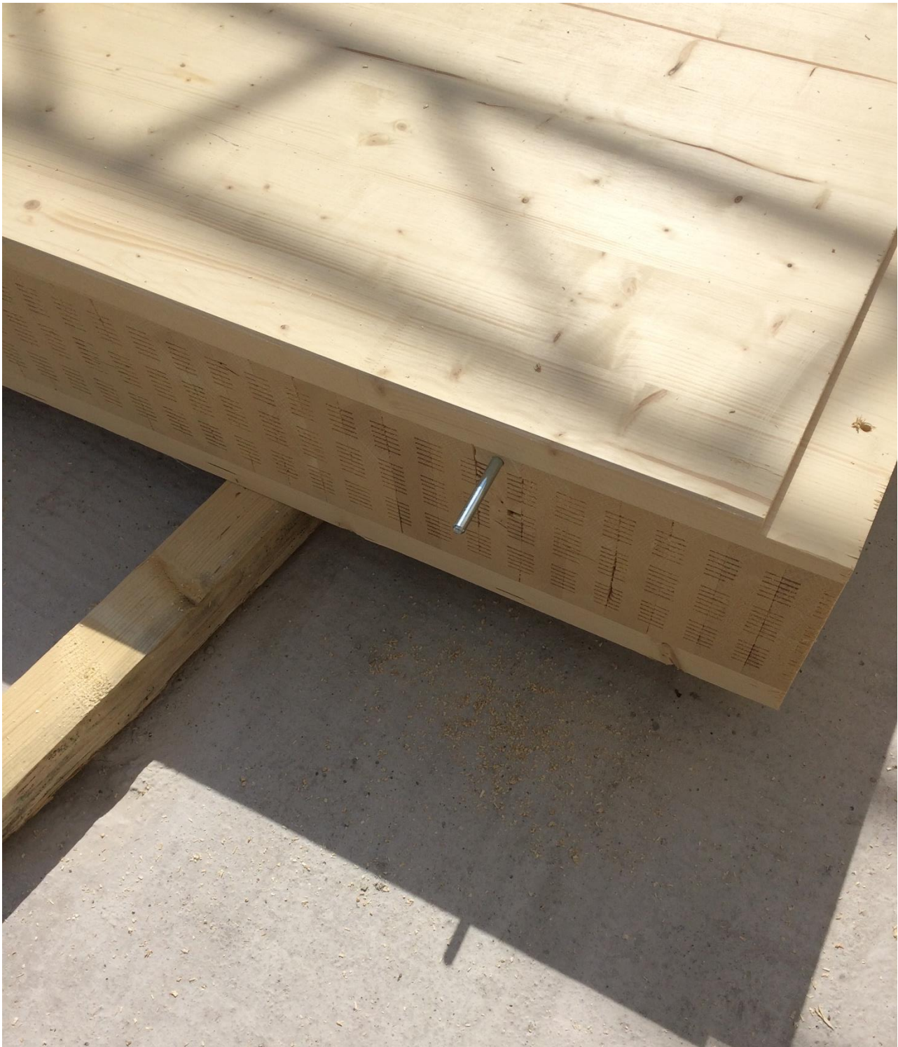
Abbildung 22: Ein 12 mm dicker Stabdübel wird oben in den Kopf der Wand gesteckt, um eine statische Verbindung zur Stahlbetondecke zu erreichen.
