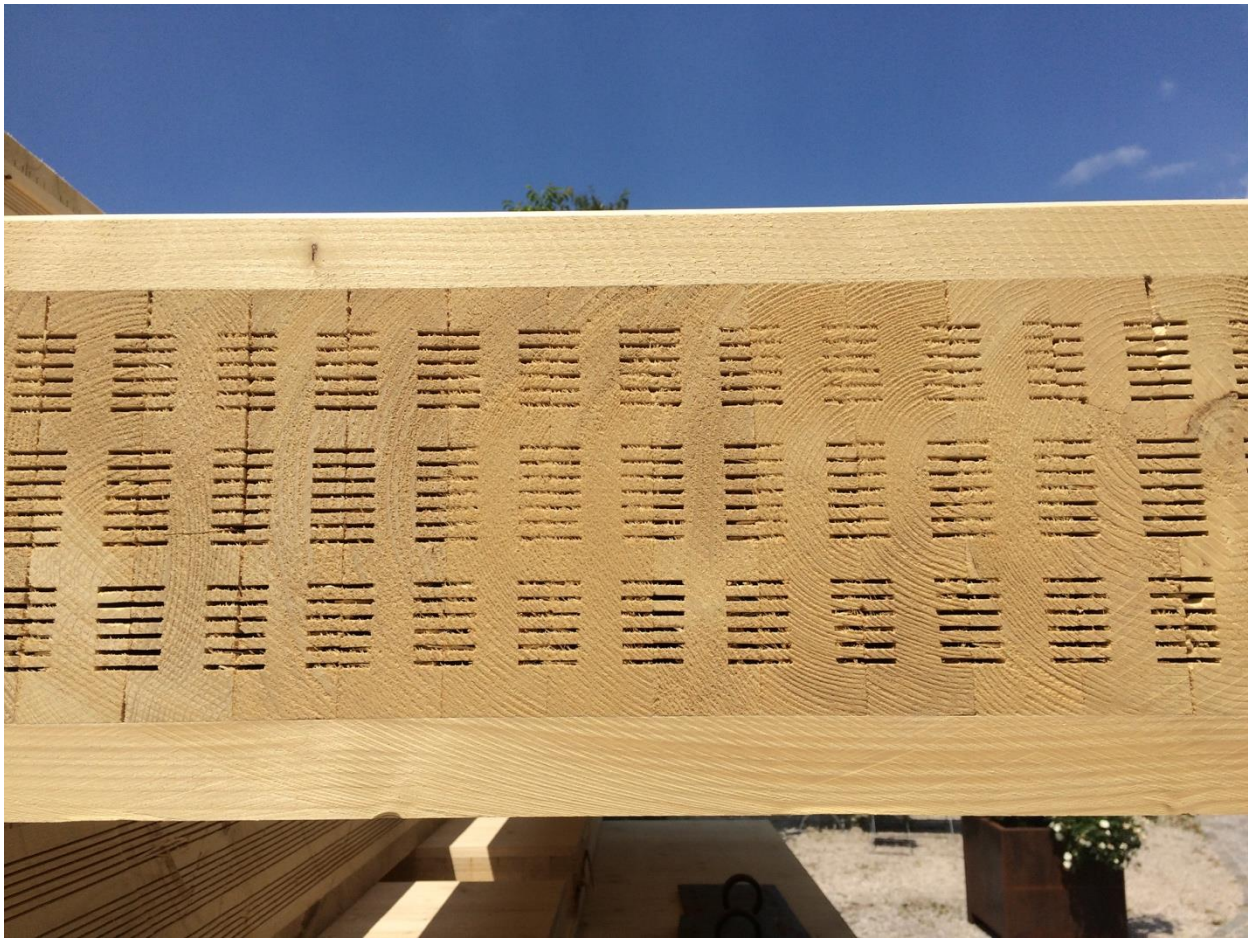
Abbildung 20: Schnittansicht der Außenwand des Holzhauses.
