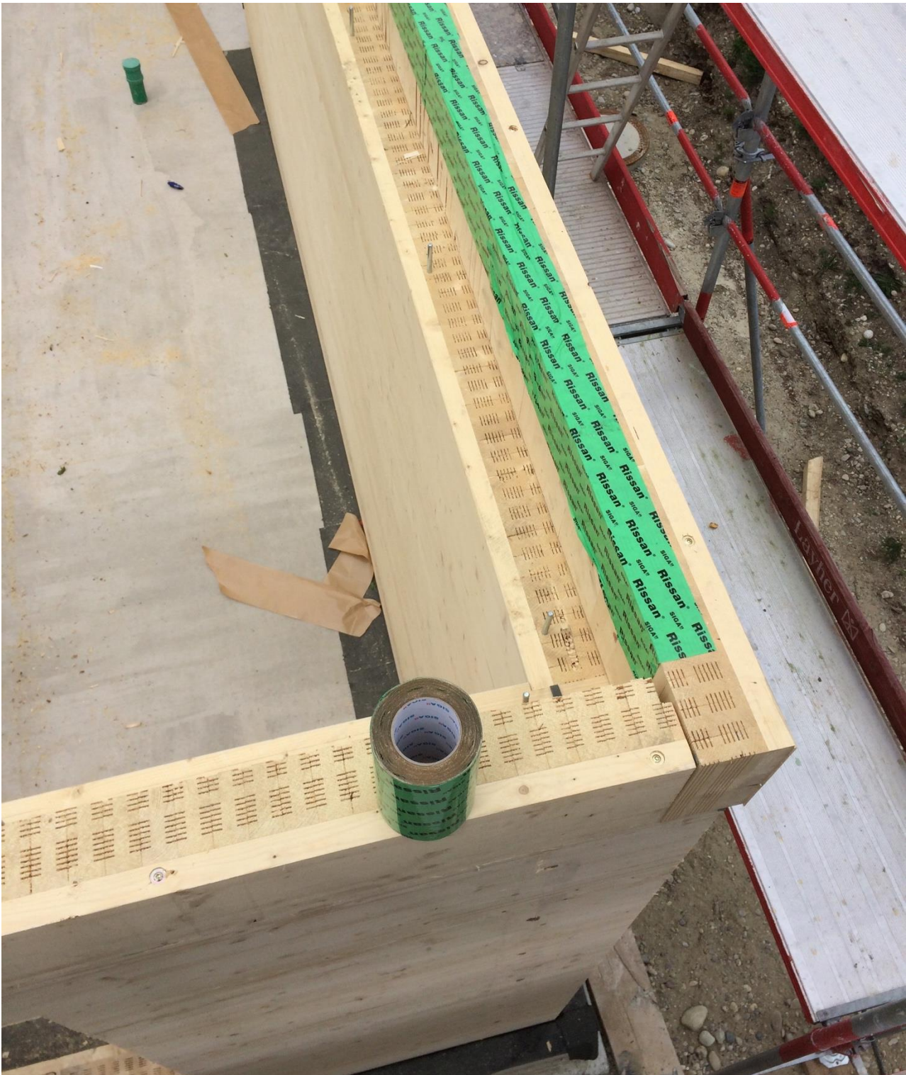
Abbildung 24: Hier ist die Aufkantung an der Außenecke zu sehen, die gleichzeitig die Randschalung für die Stahlbetondecke bilden wird.
