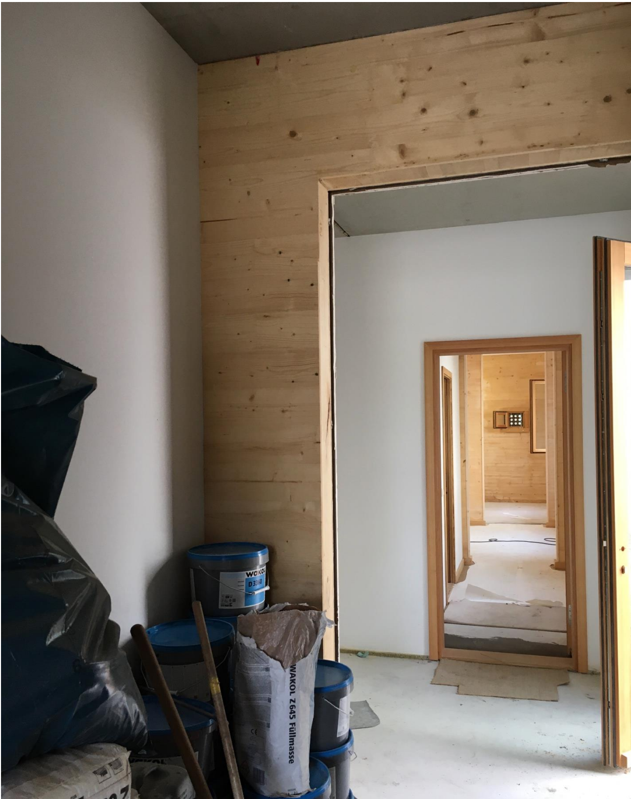
Abbildung 49: Der Bodenleger arbeitet.
