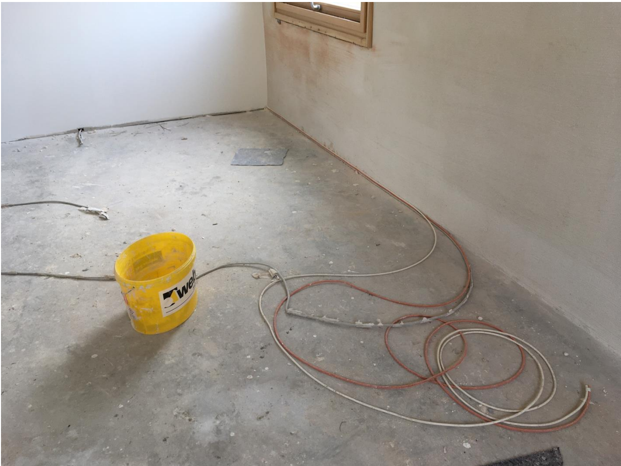
Abbildung 63: Die Elektroinstallation wird verlegt.
