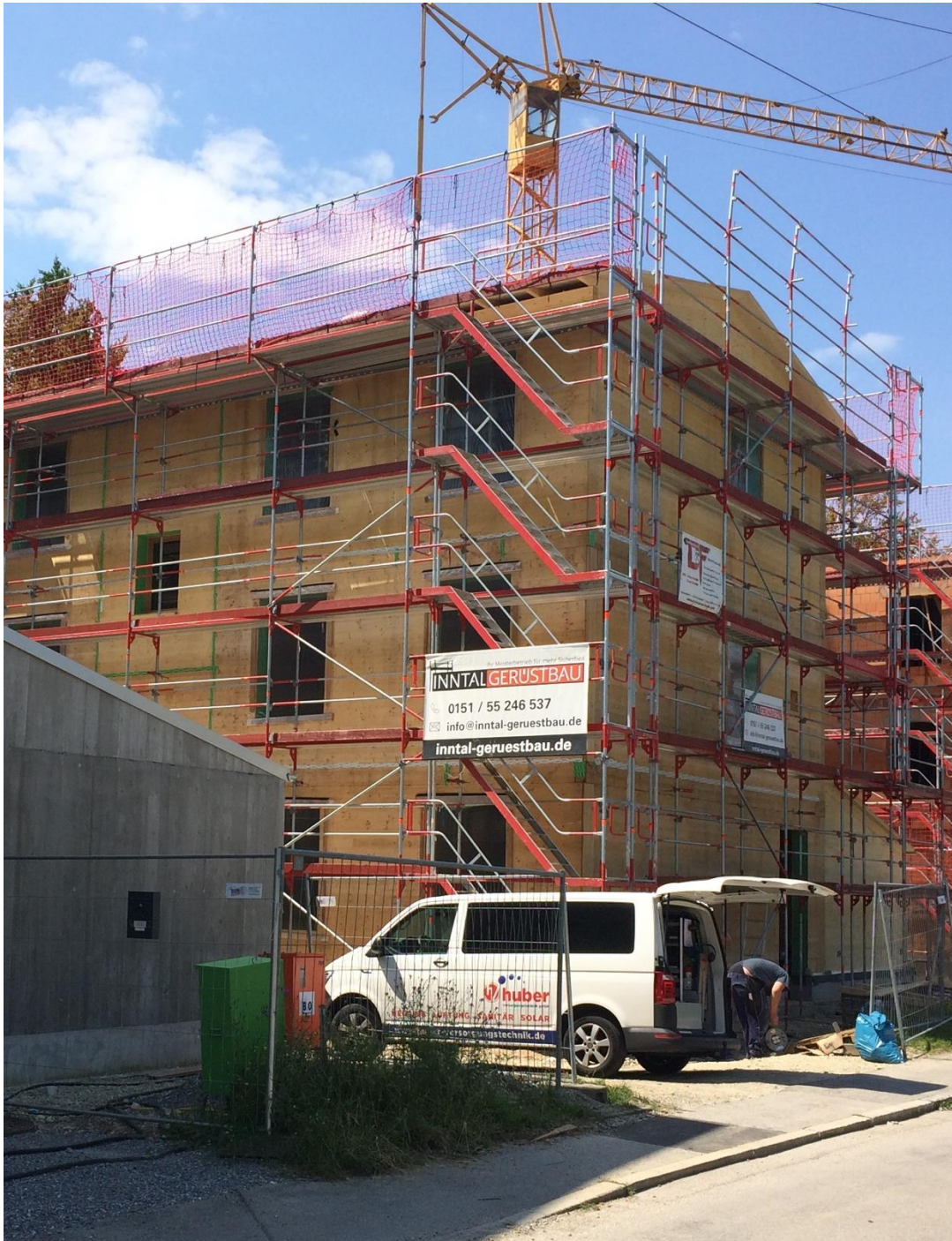
Abbildung 44: Der Dachstuhl ist aufgerichtet.
