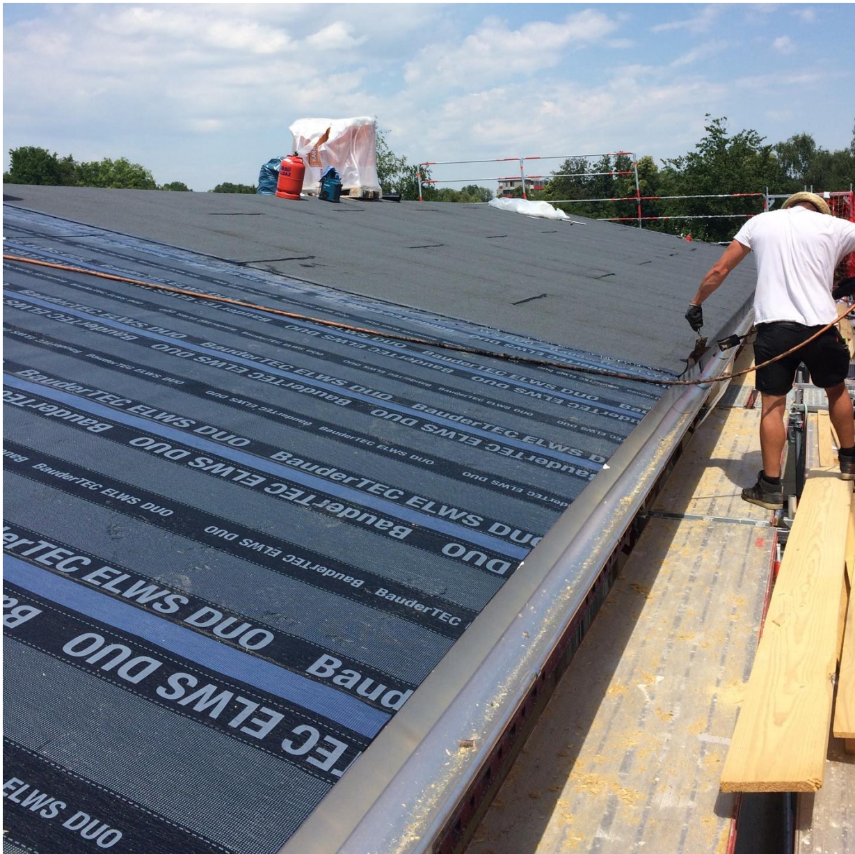
Abbildung 45: Das Dach wird eingedichtet.
