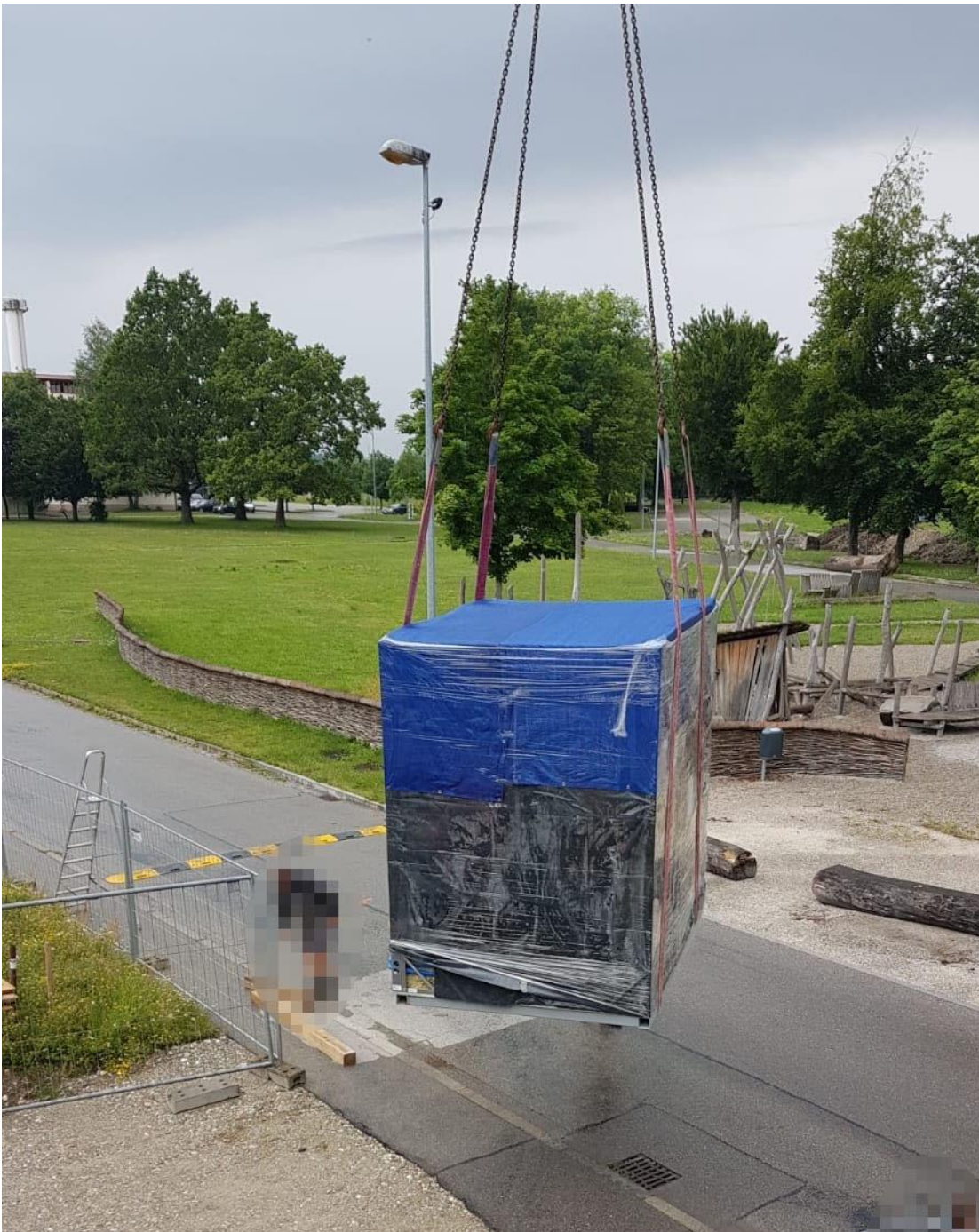
Abbildung 9: Eine vorgefertigte Badzelle wird in den Rohbau eingebracht. Sämtlich Bäder wurden in allen drei Forschungshäusern vorgefertigt.
