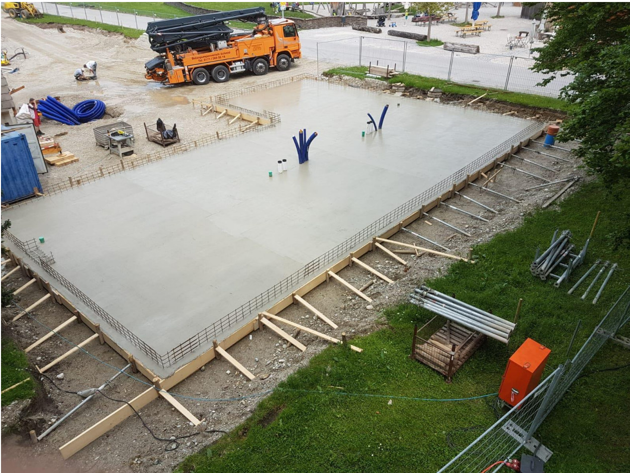
Abbildung 2: Die Bodenplatte ist betoniert.
