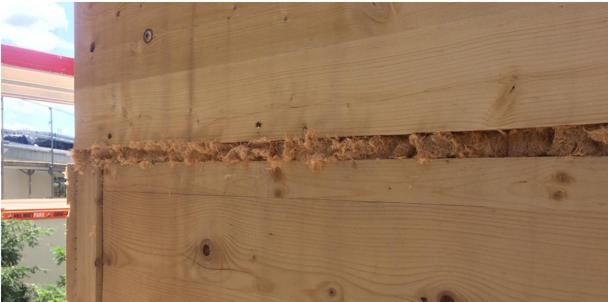
Abbildung 38: Auch von Geschoss zu Geschoss wird an den Außenwänden eine Fuge ausgebildet.
