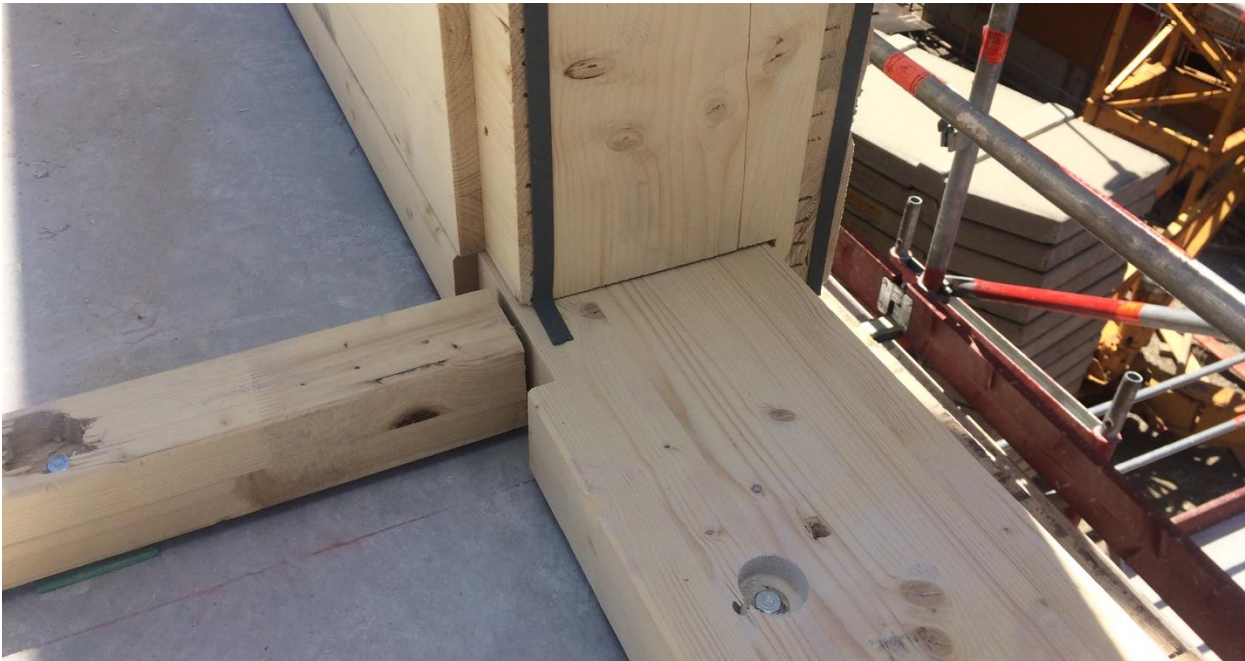
Abbildung 36: Hier ist eine Außenwand montiert. Links ist das Holzprofil für die Innenwand sichtbar.
