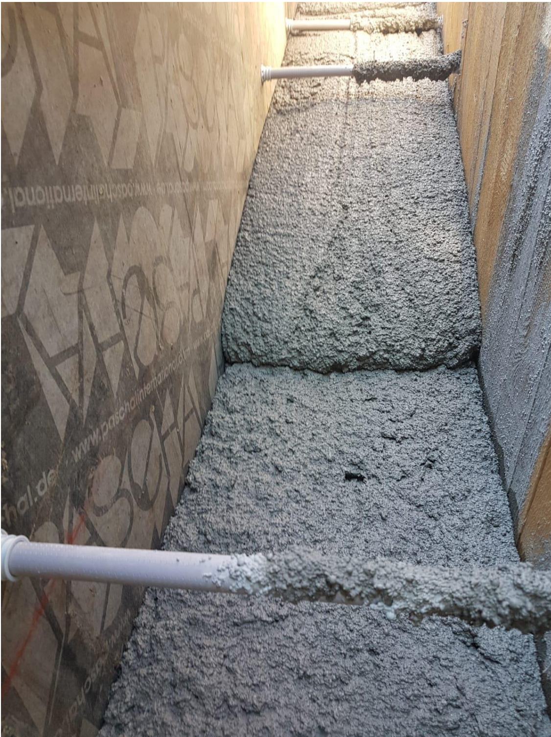
Abbildung 4: Blick von oben in die geschalte Außenwand.
