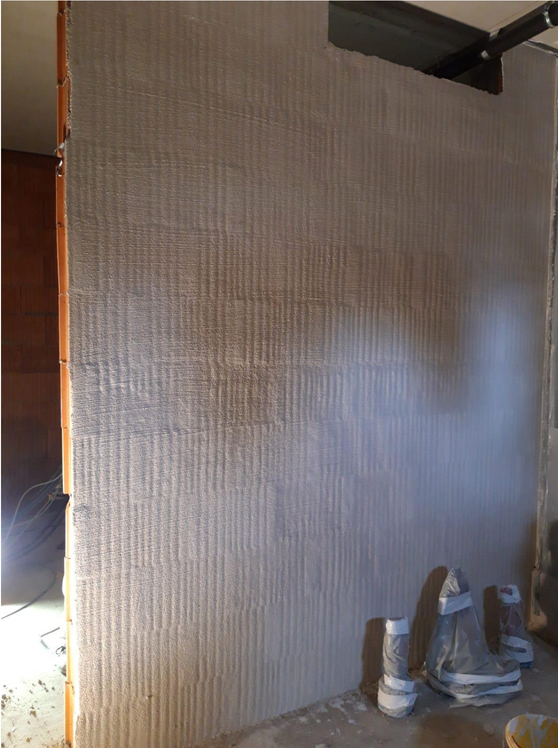
Abbildung 61: Die Kalkschlämme auf der Innenwand wird getestet.
