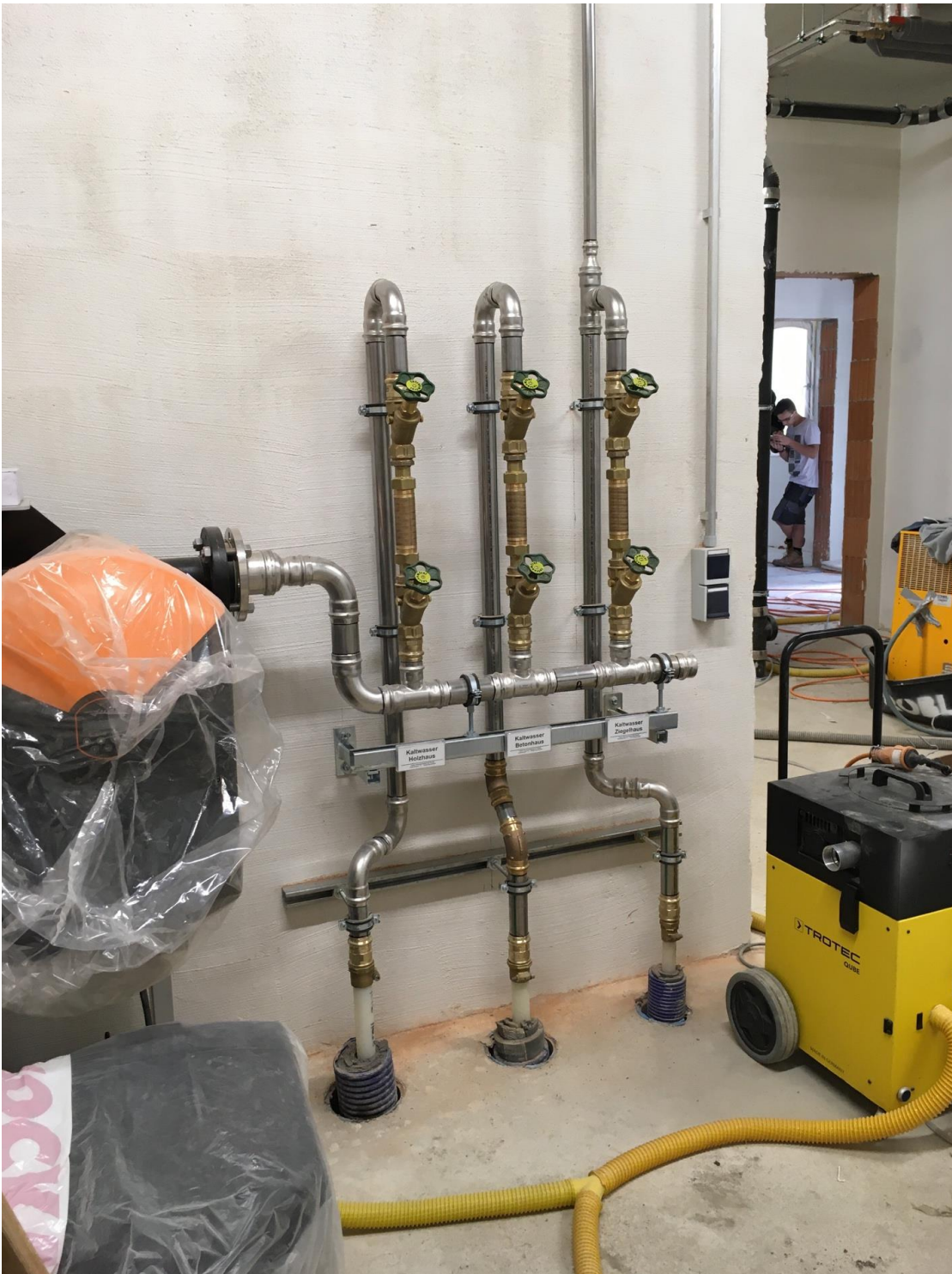
Abbildung 67: Verteilung des Frischwassers in die drei Gebäude.
