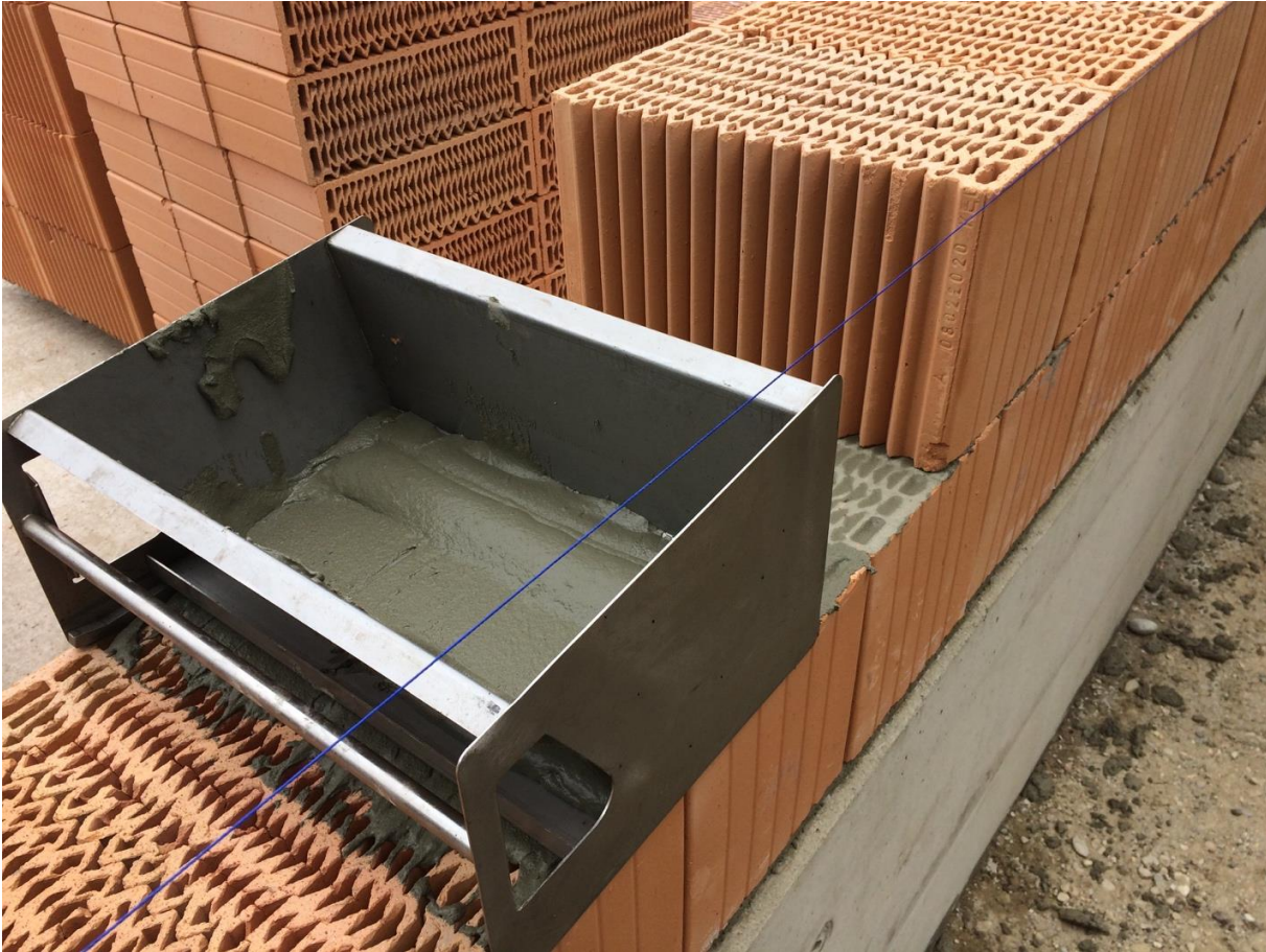
Abbildung 55: Dafür wird ein spezieller Mörtelschlitten verwendet.
