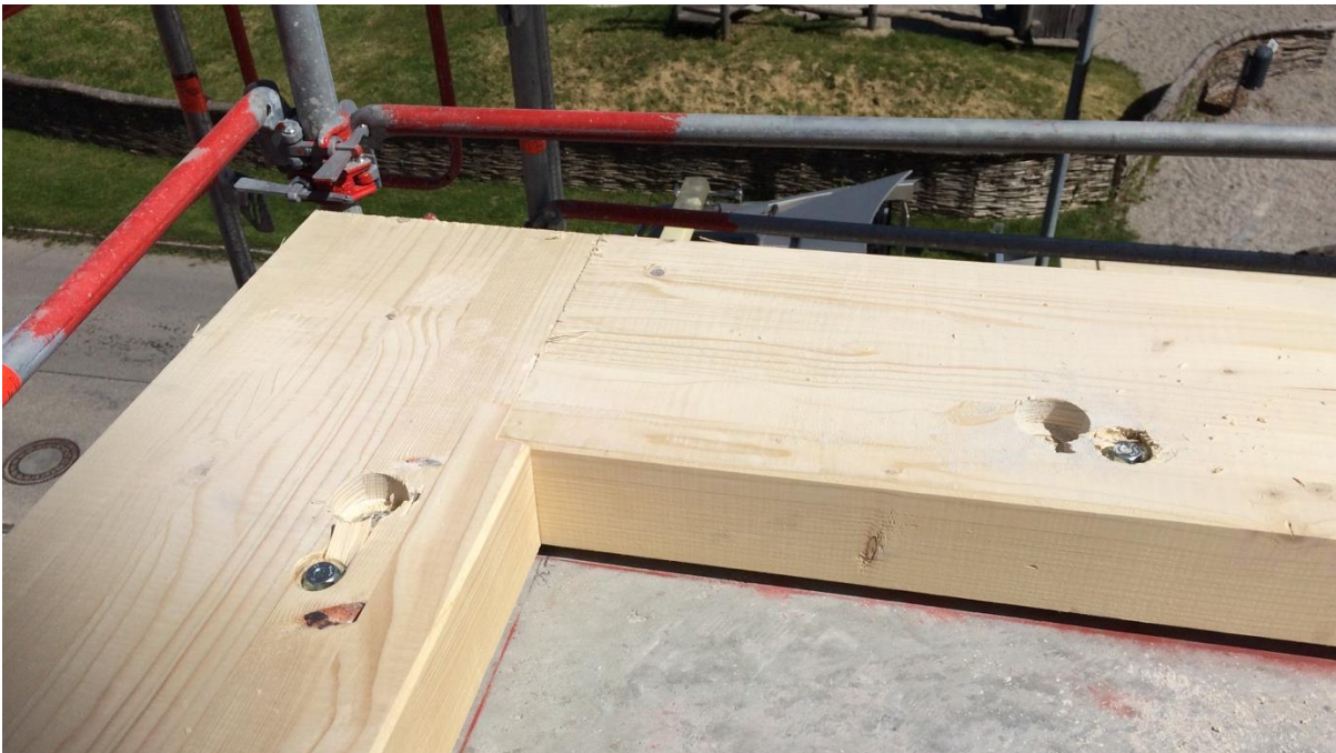
Abbildung 34: Die Holzprofile, auf denen die Außenwände lagern, werden in Lage und Höhe ausgerichtet und in der Betondecke verschraubt.
