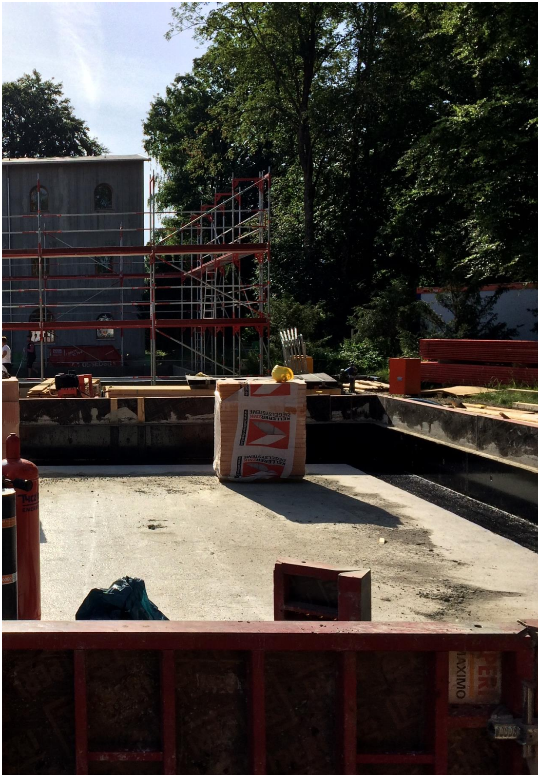
Abbildung 51: Parallel zum Holzbau begannen die Arbeiten am Mauerwerkshaus.
