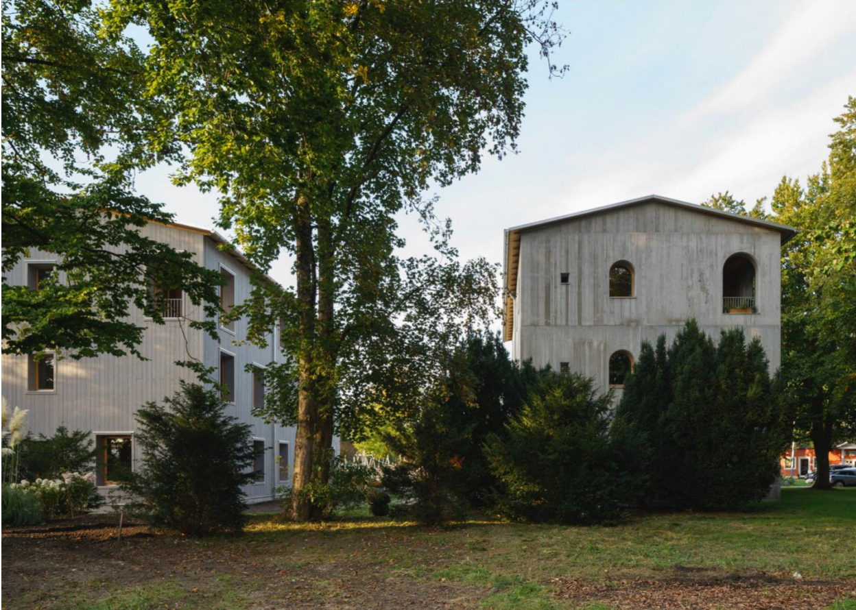
Abbildung 135: Die fertiggestellten Forschungshäuser
