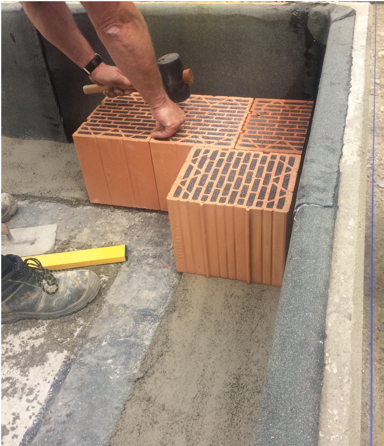
Abbildung 52: Der Kimmstein wird gesetzt.
