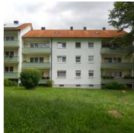
Abb. 13: Außenansicht vor der Modernisierung
