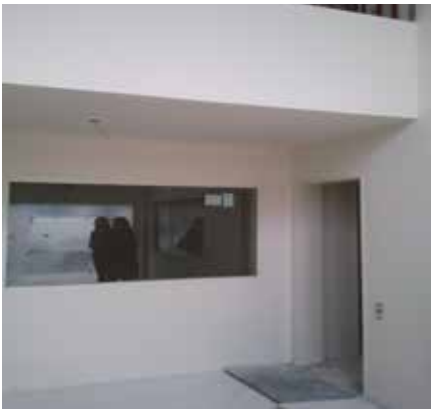
Abb. 140: Blick vom Gemeinschaftsbereich zu den Wohnungseingängen
