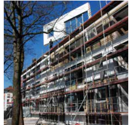
Abb. 37: Einbau der Fassadenelemente
