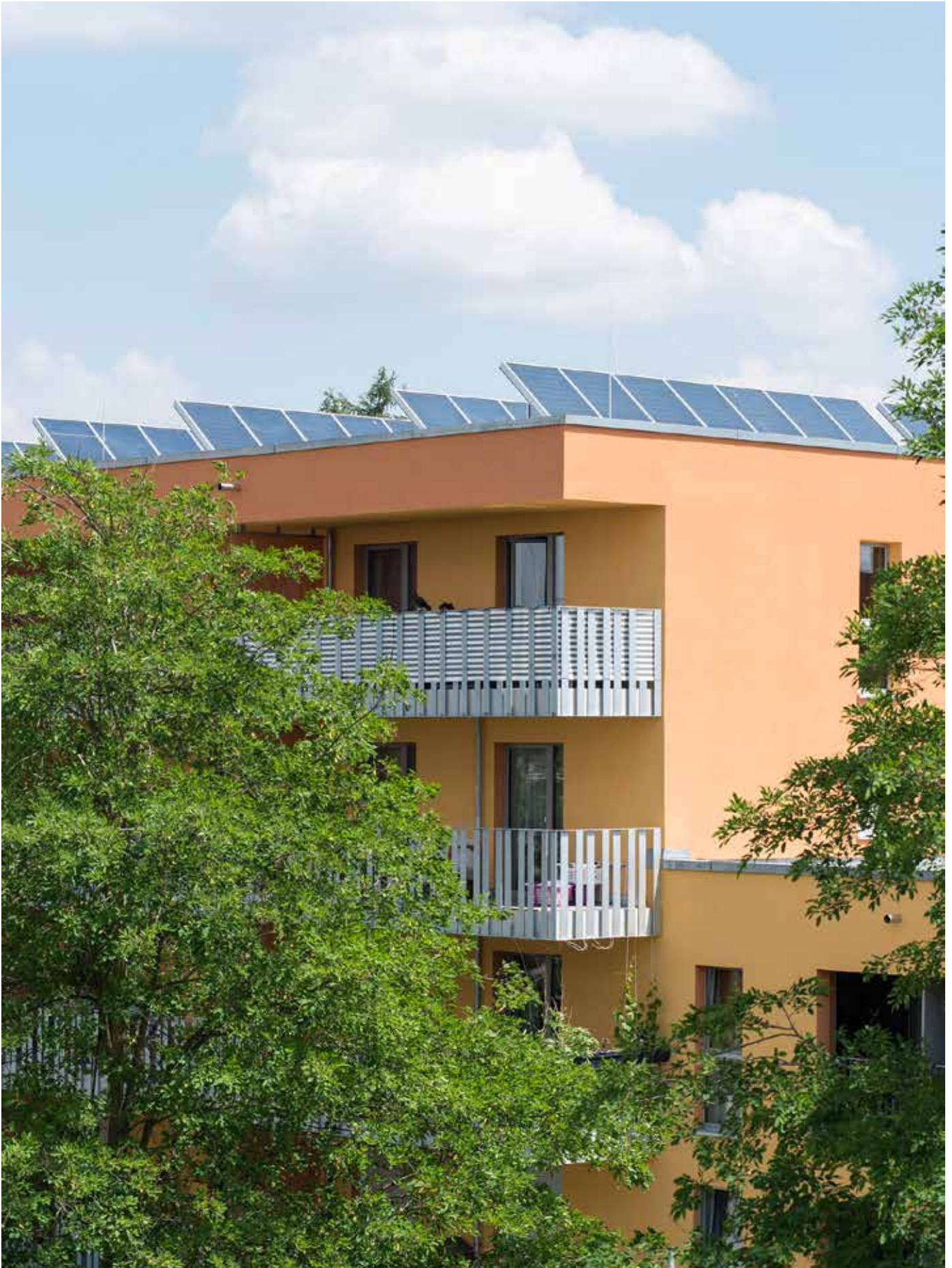
Abb. 111: Viergeschossiger Baukörper mit solarthermischer Anlage und Zwischenbaukörper
