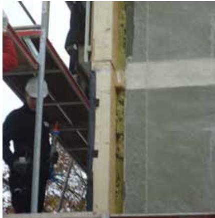
Abb. 36: Hinterfüllung der neuen vorgesetzten Fassade
