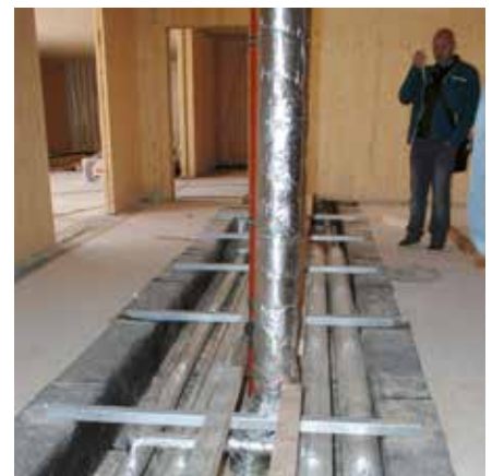
Abb. 58: Bodenkanal unter der EG-Bodenplatte
