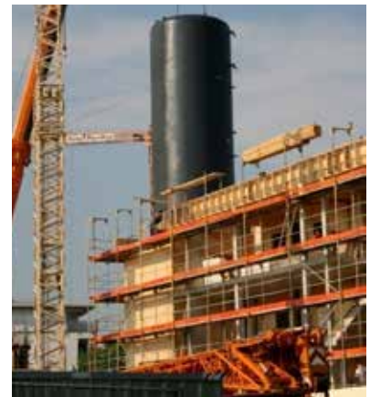
Abb. 78: Einbau des Pufferspeichers
