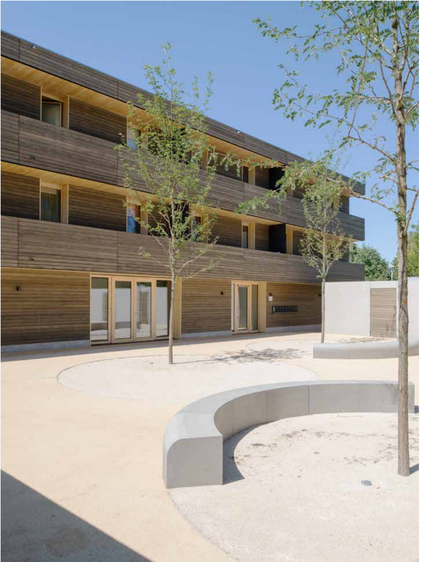
Abb. 45: Ost-Fassade zum gemeinschaftlichen Innenhof und Nebengebäude
