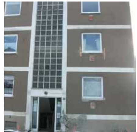
Abb. 173: Außenansicht in Augsburg vor der Sanierung
