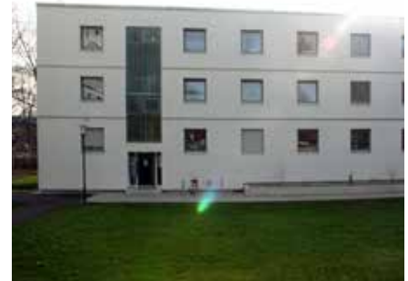
Abb. 44: Foto: Dreigeschossiger Baukörper
