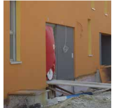
Abb. 170: Luftdichtigkeitsmessung während der Bauphase in München
