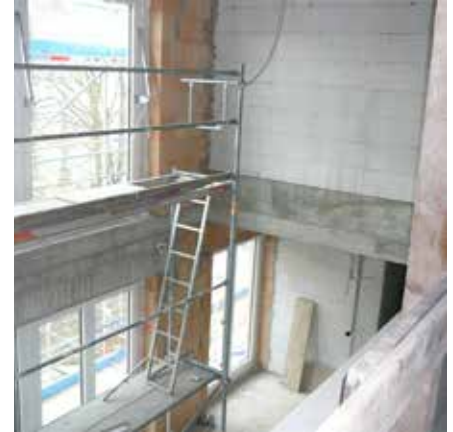
Abb. 179: Innenausbau in Neu-Ulm
