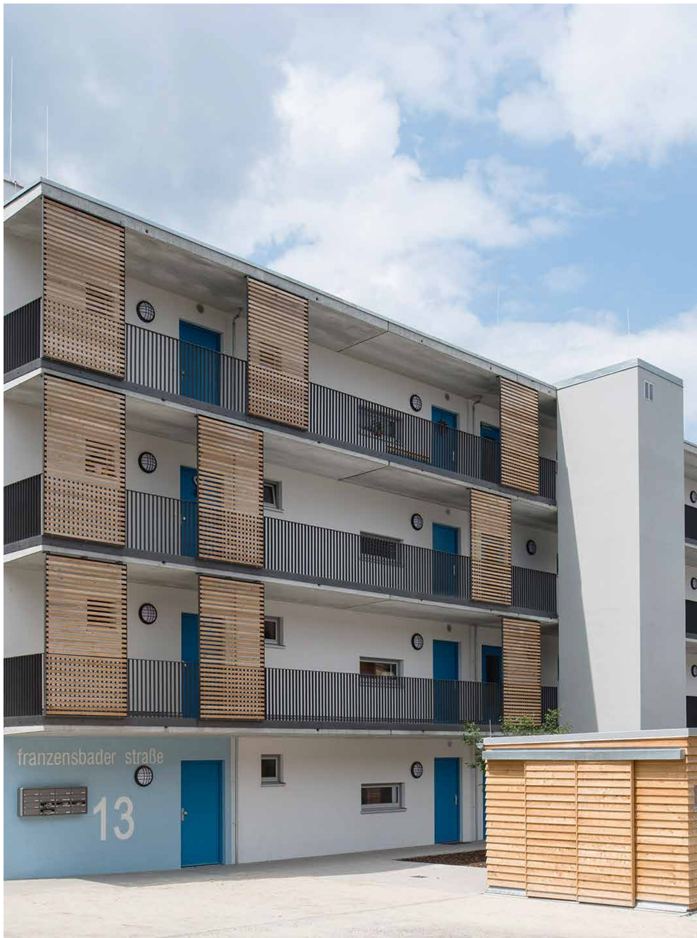
Abb. 96: Ost-Fassade mit Laubengängerschließung
