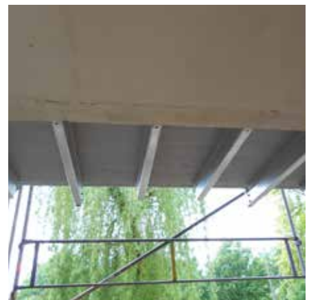
Abb. 17: Verlängerung der Balkone
