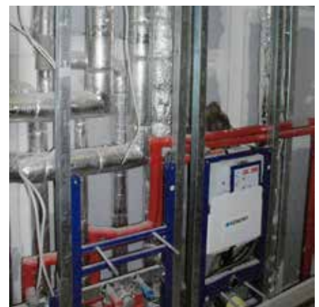
Abb. 59: Installationswand im Bad
