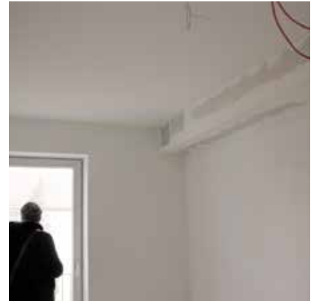
Abb. 110: Abkofferung für die Abluft im Schlafzimmer
