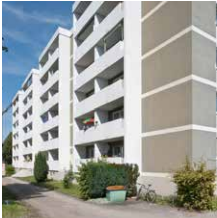
Abb. 156: Das Projekt in Augsburg vor der Sanierung
