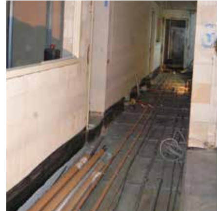
Abb. 143: Leitungsverteilung in der Erdgeschossdecke
