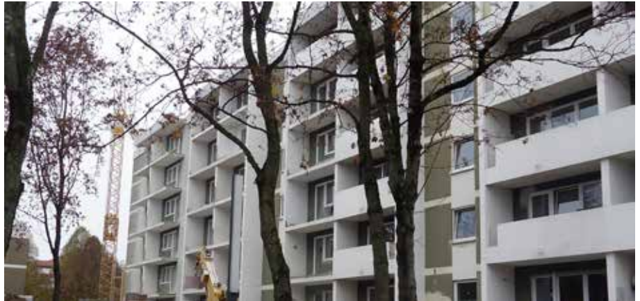
Abb. 34: Fassade kurz nach Beginn der Sanierungsmaßnahmen
