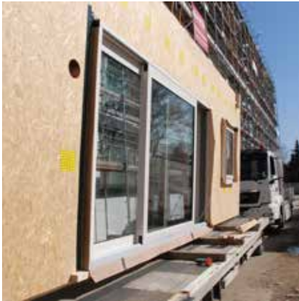
Abb. 35: Lieferung der neuen Fassadenelemente
