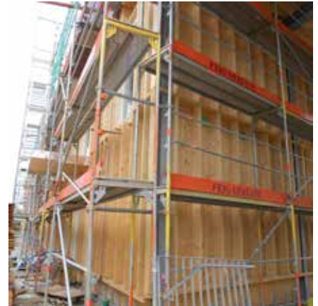
Abb. 76: Holzwand im Rohbau
