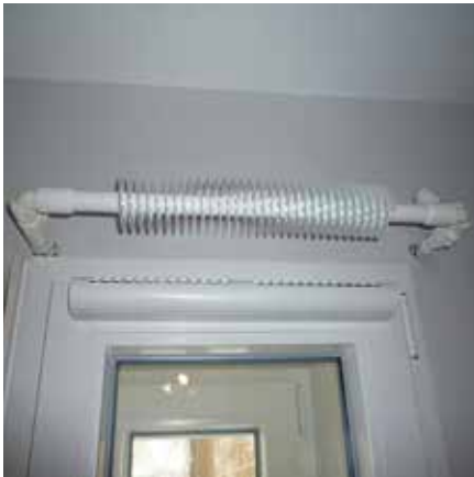
Abb. 21: Kastenfenster mit Rippenheizkörper
