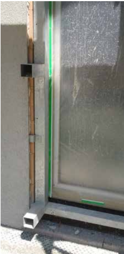
Abb. 141: Anschluss der Fensterrahmen
