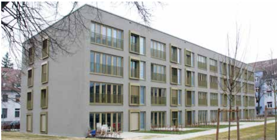
Abb. 133: Süd-West-Ansicht des Gebäudes
