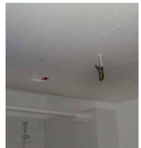
Abb. 127: Teilabgehängte Decke im Badezimmer
