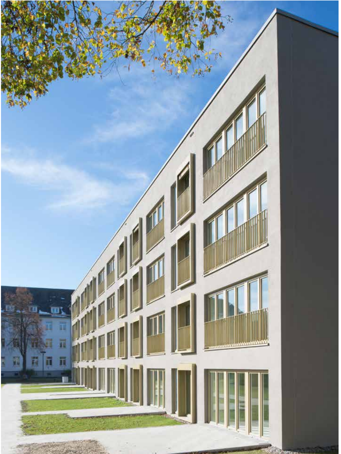
Abb. 128: Süd-Fassade mit privaten Freiflächen
