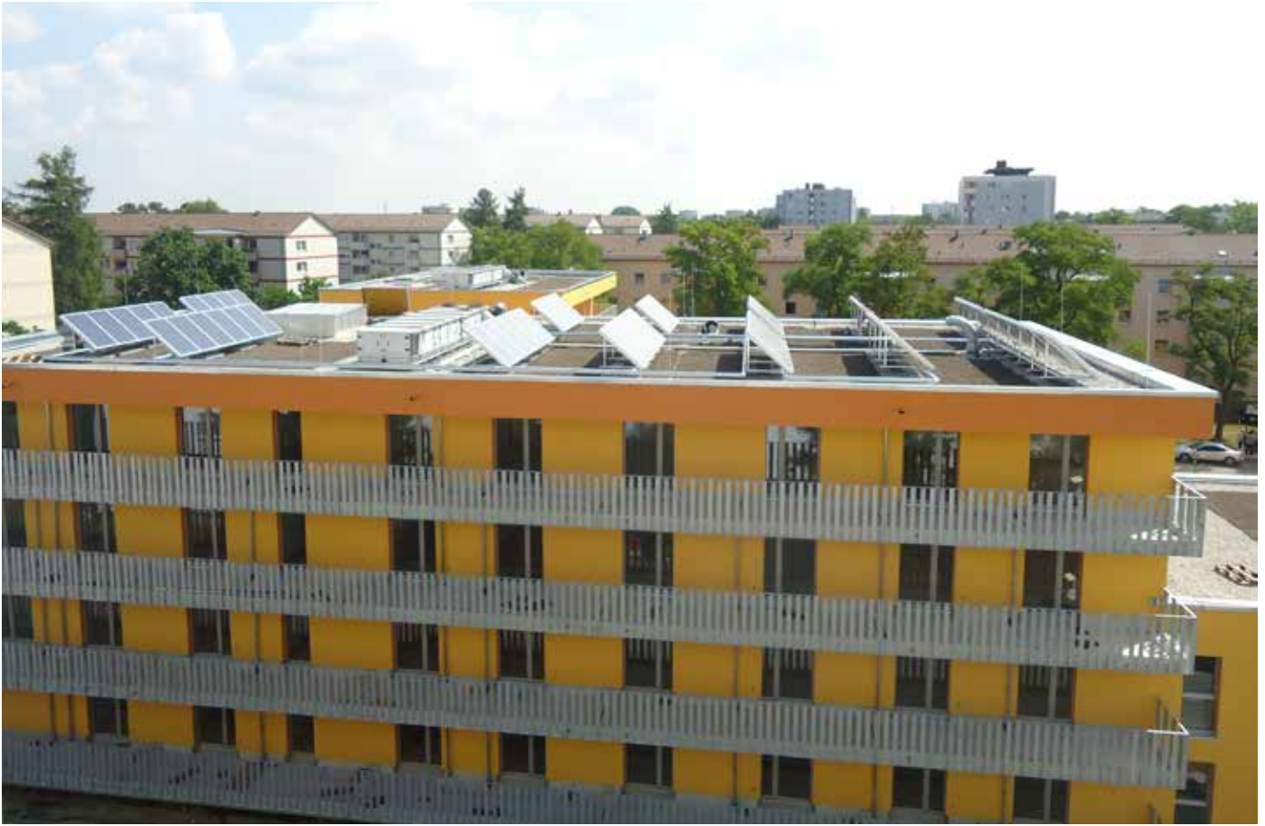
Abb. 124: Technikkomponenten auf dem Dach
