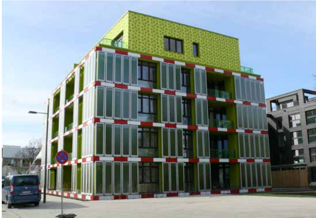
FIG. 2 Bioreactorfacade at the BIQ Das Algenhaus
