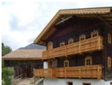
4 Alte Schmiede im Unterdorf, Sanierung
