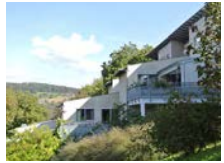
4 Wohnanlage Tiggring, Eva Rubin Architektin, 1999
