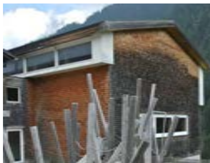
1 Mehrzweckhalle, Gion A. Caminada, 2003
