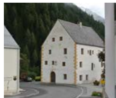
2 Sanierung Widum, Schneider Lengauer Architekten, 2007
