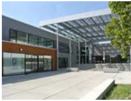
1 Gemeindezentrum Oberpriller Arch., 2017
