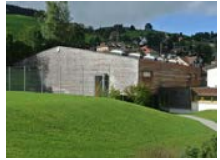
5 Turnhalle Au, Bollhalder Eberle Architektur, 2006
