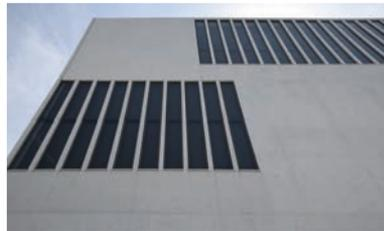
Kantenlänge von 22,5 Metern. Der spezielle weiße Sichtbeton ist genau so prägend für die Fassaden, wie die Fensterschlitze, die die Fassade auflockern. Die großen Fenster lassen einen Sichtbezug zu den baulichen Relikten der NS-Zeit zu. Auch die Innenraumgestaltung besticht durch die bisweilen als kühl beschriebene
