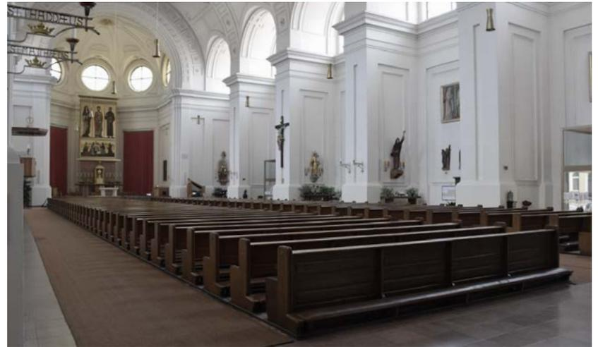
Der Architekt errichtete eine Hallenkirche mit Tonnengewölbe, das von den Seitenpfeilern getragen wurde. Die Abmessung des Kirchengebäudes sind beachtlich. Die Länge misst 79 Meter, die Breite 31 Meter und die Distanz zwischen Fußboden und Gewölbescheitel bemisst 24 Meter. Der Turm erreicht eine Höhe von 63 Metern.
