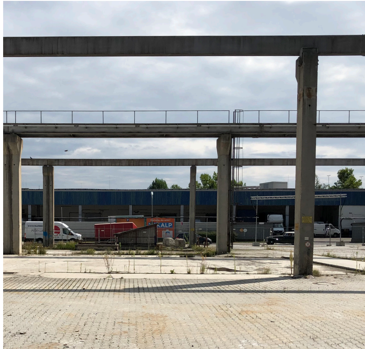
Blick vom Zentralen Platz nach Süden mit den bestehenden Kranbahnen
