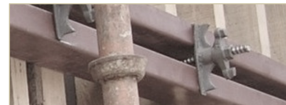
Spurstangen zum Verschließen (Schalungsanker)
