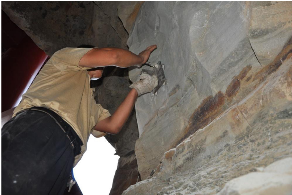
Fig. 19: Planting bar (oblique upward)
