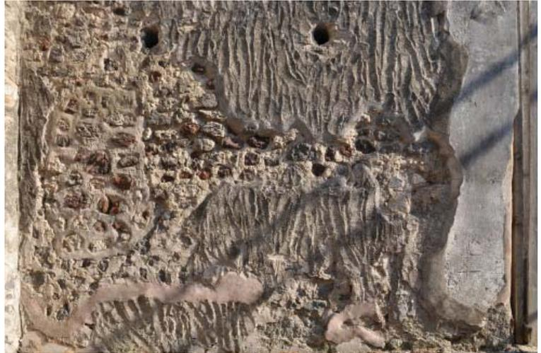
Abb. 10: Pompeji, Casa del Labirinto (VI, 11, 8–10), Raum 32, Südwand: *trullissatio*
