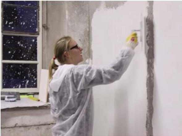
Abb. 8: Auftragen der fünften Putzlage
