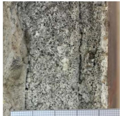
Abb. 1: Aufbau eines antiken römischen Wandputzes am Beispiel der Casa delle Nozze d'Argento, Pompeji, Raum x
