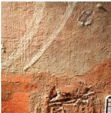
Abb. 6a: Glättstufe 1 – Ungeglättet, mit deutlichem Pinselektus (Foto: N. Riedl)
