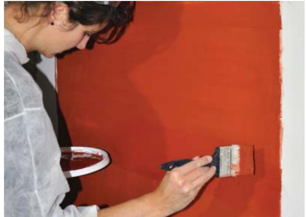
Abb. 11: Dritter lasierender Farbauftrag
