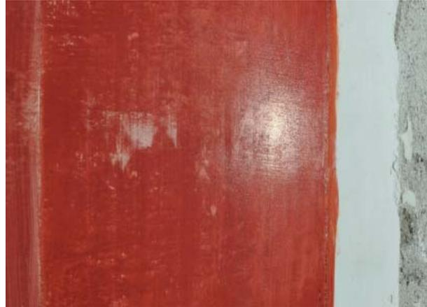
**Abb. 15:** Zinnober mit Leim auf Putz mit Kluftcalcitzuschläge, Glanzeffekt
