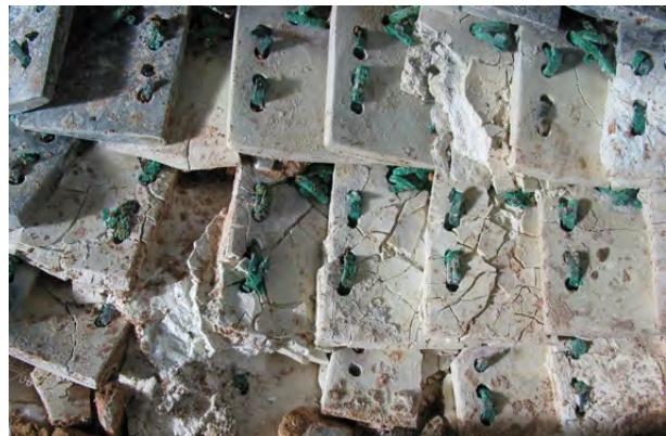
**Abb. 2:** Schaden durch Feuereinwirkung: Weißfärbung, Rissbildung, Pulverisierung
