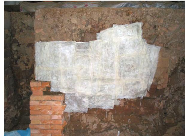
Abb. 5b: Sicherung der Putz- und Grundierungsreste mit Cyclododecan
