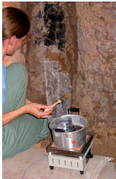
**Abb. 4b:** Auftrag des Schutzfilms mit Cyclododecan
