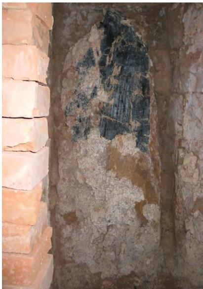
**Abb. 4a:** Verkohpter Stützbalken aus Holz
