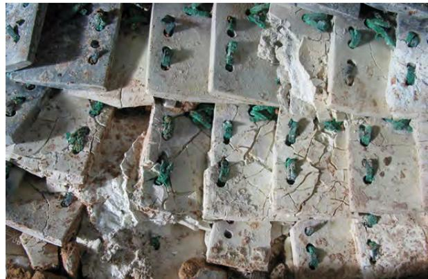
**Abb. 2:** Schaden durch Feuereinwirkung: Weißfärbung, Rissbildung, Pulverisierung
