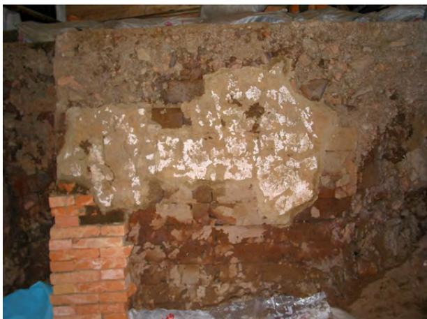
**Abb. 5a:** Reste von originalem Putz und Grundierung
