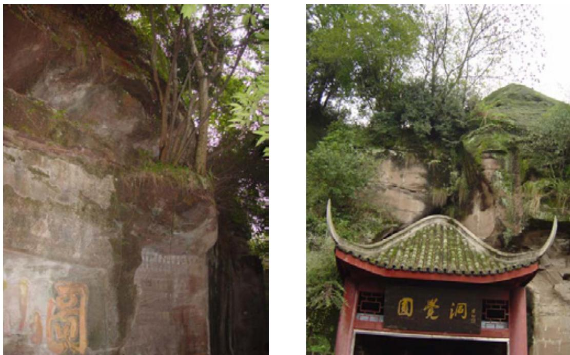
图 5-1 裂隙中根系发育产生生物风化病害
