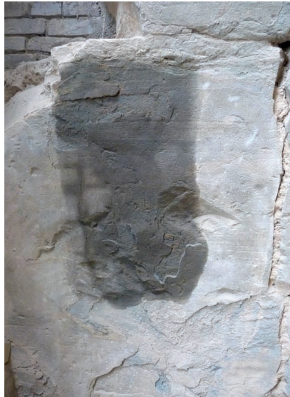
Abb. 11: Übersicht Musterfläche 2, nach der Festigung / Fig. 11: Overview, after consolidation
