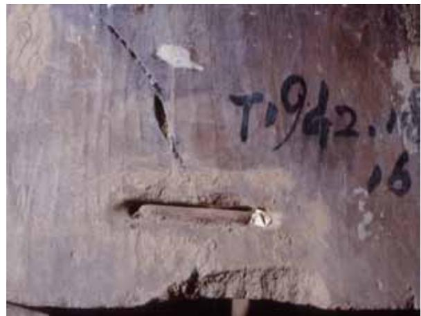
Abb. 4 | Metallklammern als Verbindungshilfen
