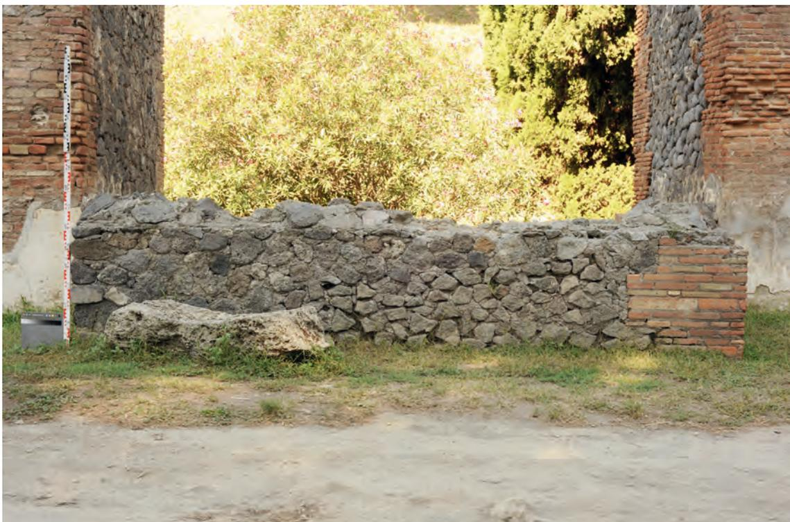
**Kurzbeschreibung:** Einfriedungsmauer aus Lava-Bruchsteinmauerwerk (Opus incertum), Ziegelmauerwerk der östlichen Eckverstärkung ist Ergebnis einer Reparatur (KASTENMEIER 2014); Mauerabschluss mit moderner Abdichtung.
