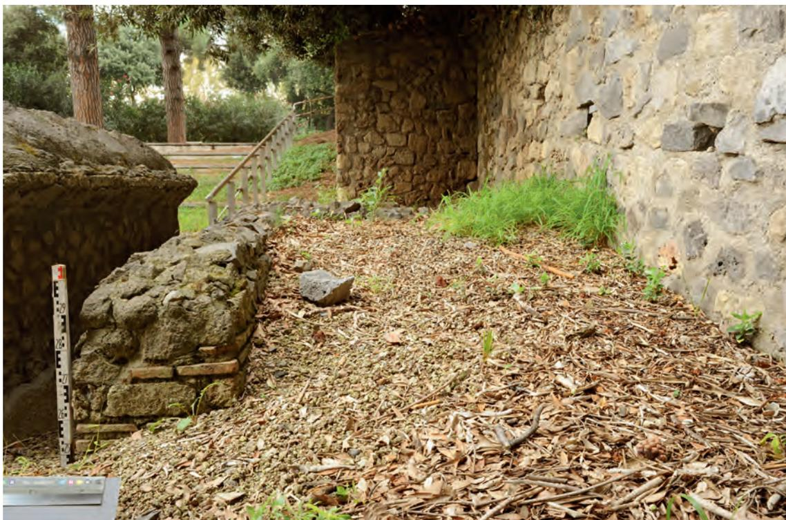
**Kurzbeschreibung:** Einfriedungsmauer; Opus vittatum mictum aus Ziegel- und Travertinlagen (KASTENMEIER 2014); obere Mauerkante mit moderner Abdichtung; Einfriedung vollständig mit Erdreicht gefüllt; Grabbezirk grenzt im Osten an eine moderne Mauer.
