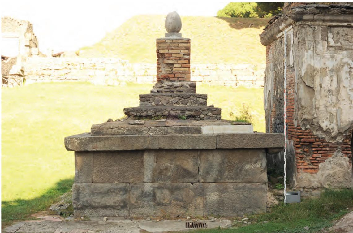
**Kurzbeschreibung:** Grabmonument mit Grabkammer (acht Nischen und Wandmalereien) und mehrstufigem Altar (D'AMBROSIO/DE CARO 1983/87); Sockel aus Tuffsteinblöcken z. T. mit Resten einer Marmorverkleidung, Treppenpyramide mit Opus incertum aus Lavastein und grauem Tuff, Ziegelaufbau mit Kalkstein-Ei (KASTENMEIER 2014); Pflanzenbewuchs im Mauerwerk, keine Putz- oder Stuckreste vorhanden.
