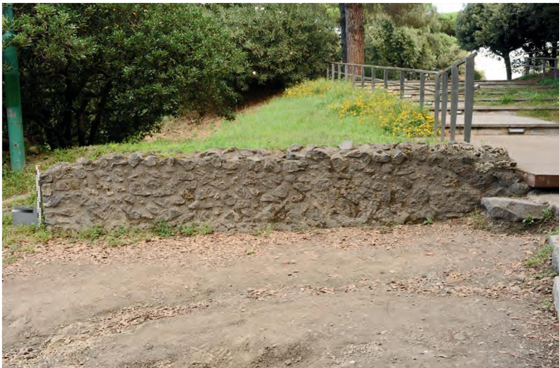
**Kurzbeschreibung:** Bruchsteinmauerwerk aus Lavastein und Travertin (vereinzelt) (KASTENMEIER 2014); obere Mauerkante abgedichtet.
