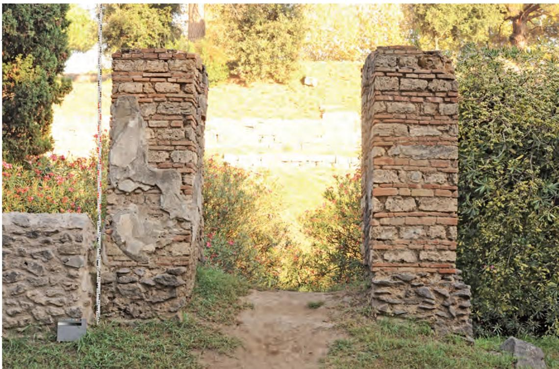
**Kurzbeschreibung:** Grabmonument ursprünglich eventuell mit Gewölbe und aufgesetzter Ädikula (D'AMBROSIO/DE CARO 1983/87); Seitenwände mit Mauerwerk aus horizontal wechselnden Ziegel- und Travertinbändern (Opus listatum), Sockel aus Lavabruchstein-Mauerwerk (Opus incertum) (KASTENMEIER 2014); Wandstücke sind windschief und deutlich geneigt; ursprünglich vermutlich weiß verputzt bzw. stuciert, rudimentäre Reste von Putz erhalten; ältere Putzanböschungen beeinträchtigen das Erscheinungsbild.
