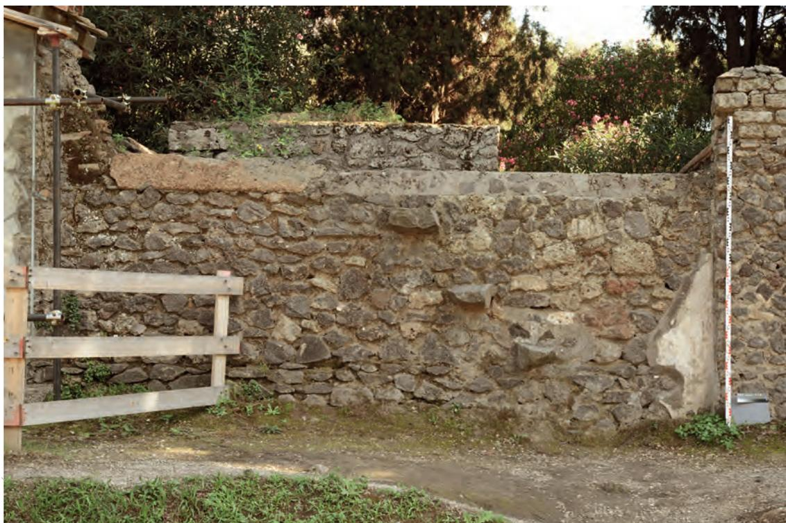
**Kurzbeschreibung:** Einfriedungsmauer, Süd- und Nordseite mit eingemauerten Stufen aus Lavagestein zur dahinterliegenden Grabkammer; Opus incertum aus schwarzem Lavastein, Travertin und rotem Cruma (vereinzelt) (KASTENMEIER 2014); Mauerkrone modern; Reste einer Cocciopesto-Abdichtung des Mauerabschlusses; minimale Reste von Putz mit älterer Anböschungen.
