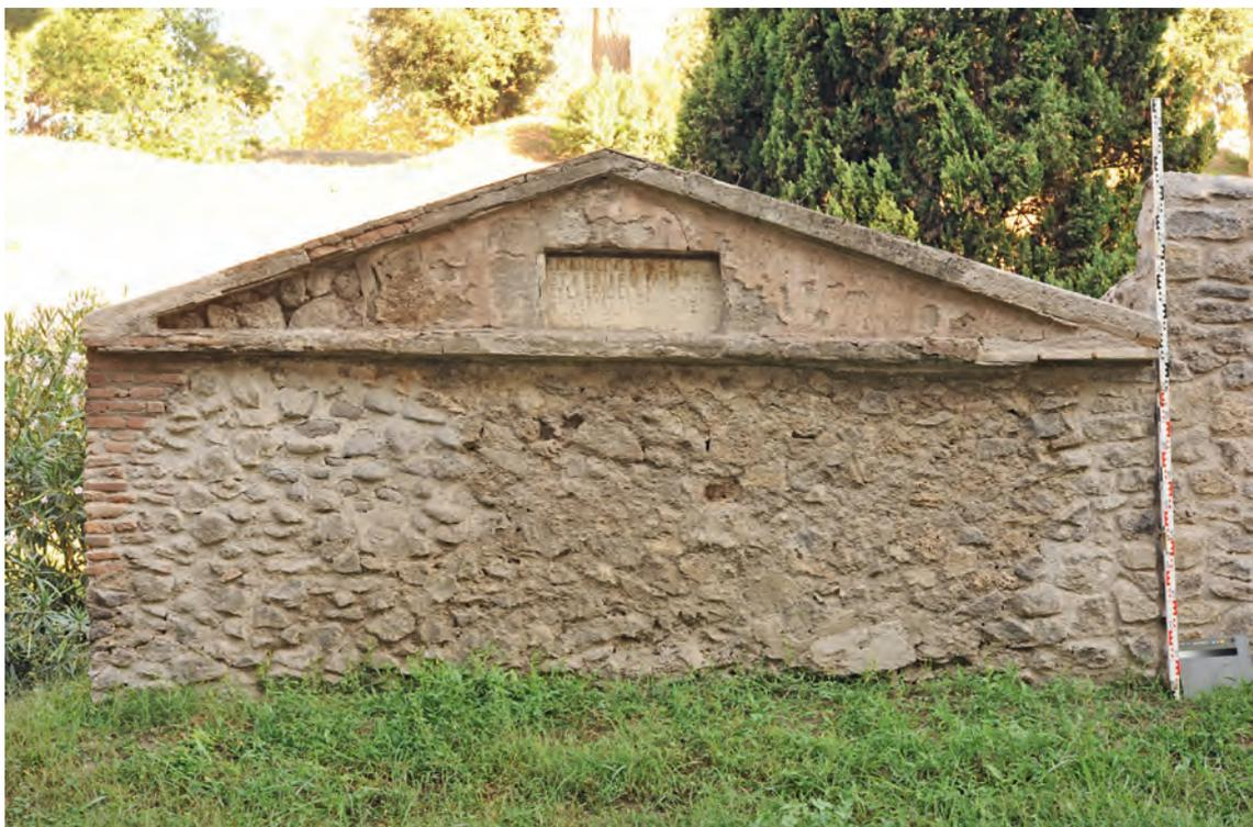
**Kurzbeschreibung:** Einfriedung mit Giebelfassade, Inschrift auf Marmortafel; Opus incertum aus Lavastein, linke Ecke und Giebel teilweise mit antiken Ziegelreparaturen (D'AMBROSIO/De Caro 1983/87); Reste von Putz im Giebelfeld; an der Seite zu EN 24 moderne Reparaturen.
