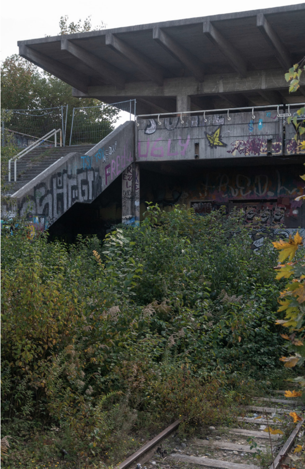
Eingangsgebäude mit Flugdach
