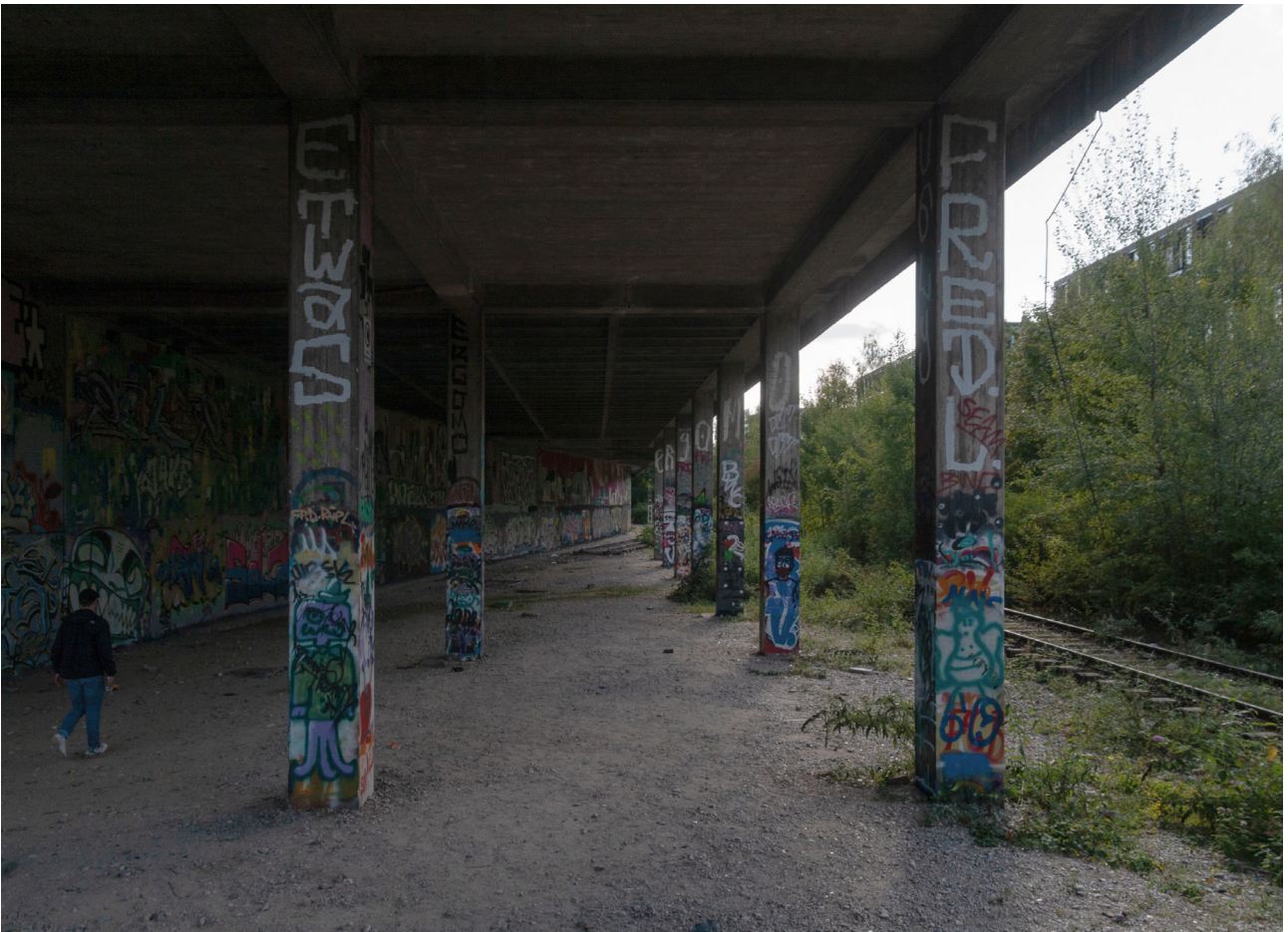
Gleise Richtung Süden unter Station
